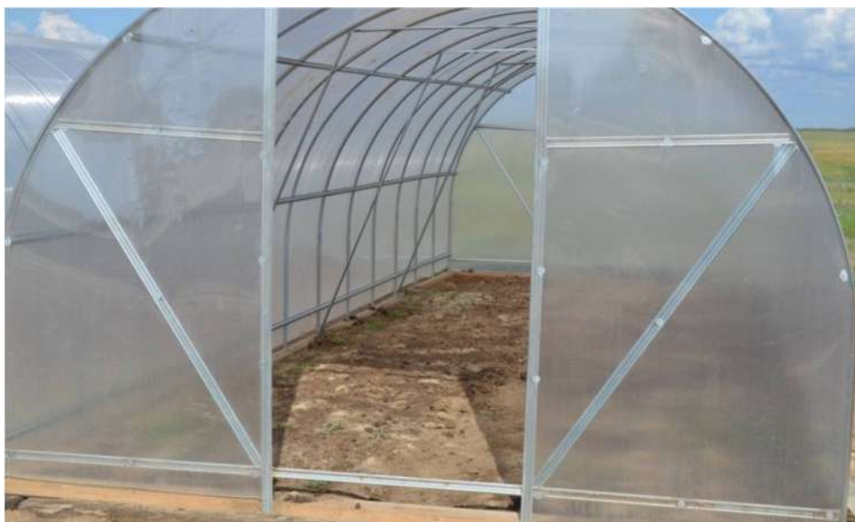
Рисунок 1 – Секция сборно-разборной теплицы для совместного выращивания грибов с овощной или ягодной культурами
