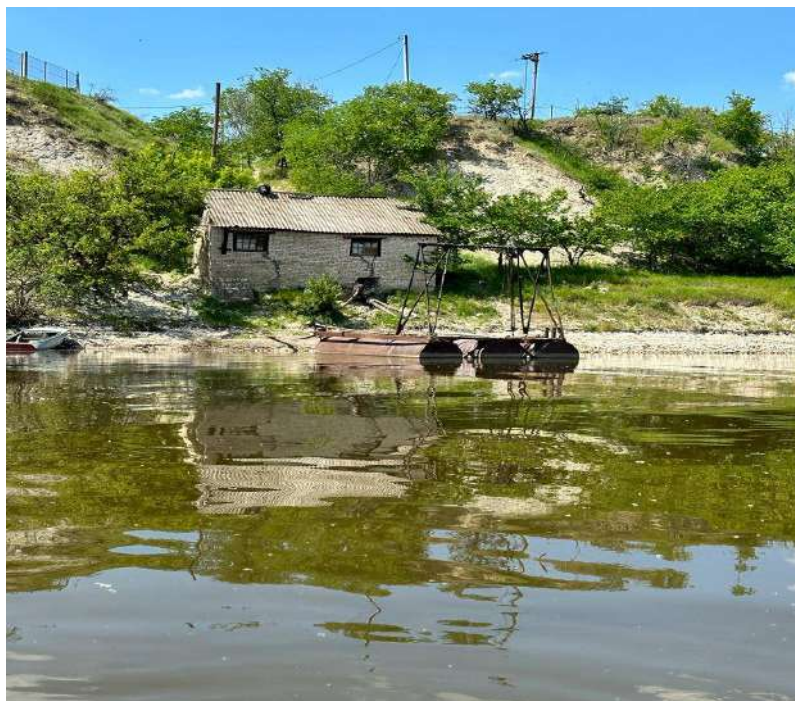
Рисунок 3 – Водозабор на первом участке Figure 3 – Water intake at the first site
