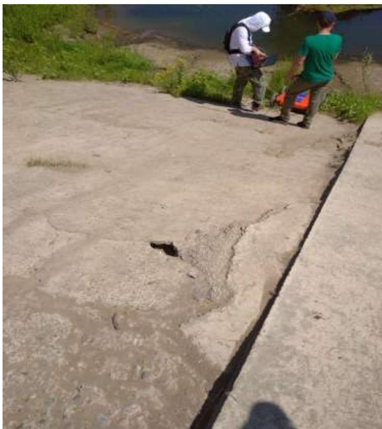
Рисунок 10 – Полость в верхней части бетонного покрытия откоса нижнего бьефа ГТС
