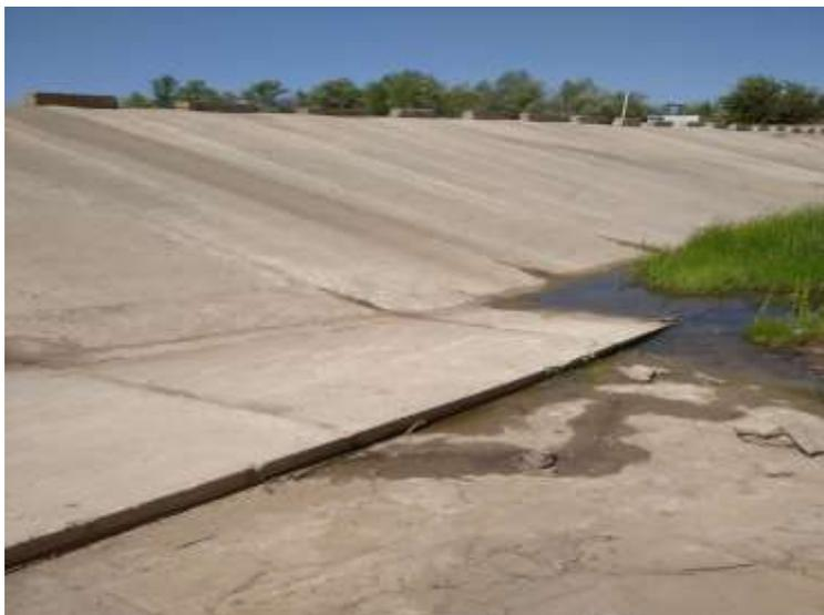
Рисунок 9 – Истечение фильтрующей воды на участке № 2
